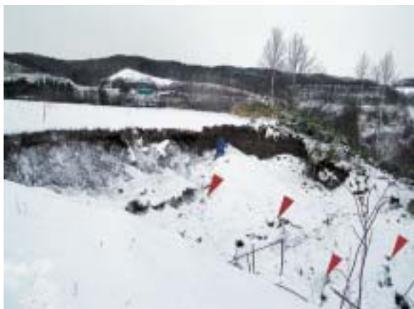
写真10 苫前町岩見, 谷埋め盛土に発生した円弧すべり. 滑落崖と斜面上に定置した移動土塊の状況. 矢印は移動土塊に発達する副次崖.
