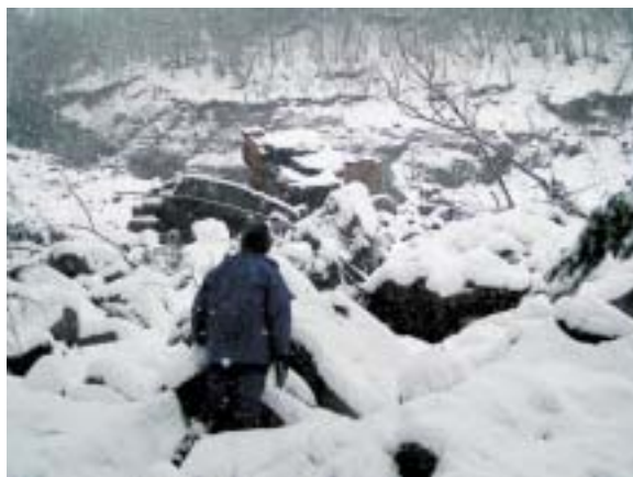
写真11 苫前町三溪南方のルペシュペナイ川右岸に発生した古丹別層砂岩泥岩互層の岩盤崩壊 (基岩すべり一崩落).
