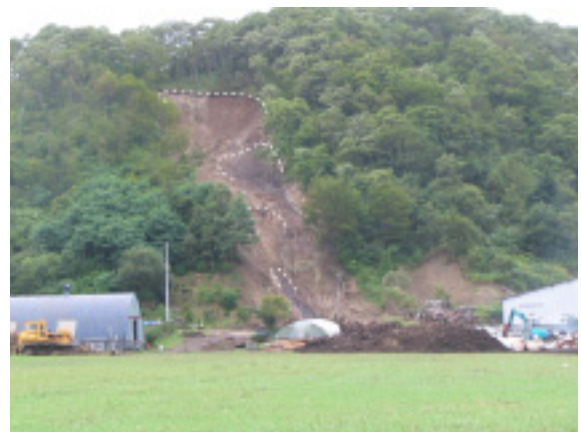
第6図 日高町平賀の斜面崩壊ステップ状の崩壊面。 Fig. 6 Stepped slide surface of the slope failure at Hiraga.
