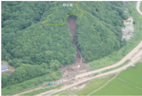
第13図 むかわ町春日三区 (Loc. 3) の斜面崩壊 (株シン技術コンサル8月19日撮影) 白色破線矢印は崩壊物質の, 青色破線矢印は水路を流走した土砂の移動方向を示す。
