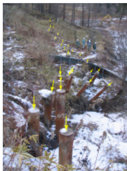
第22図 平取町仁世宇(Loc. 8)の斜面崩壊 地すべり土塊が変形しながら抑止杭(千鳥状配列)を前方へ押し倒した。(2007.1.9.撮影) 矢印で杭の位置を示す。 Fig. 22 Landslide bent steel piles at Niseu, Biratori Town.
