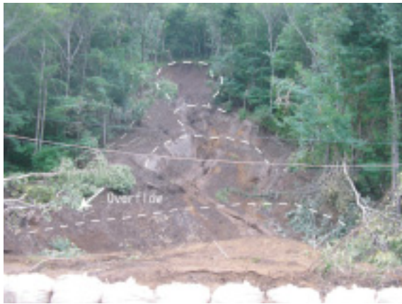
第10図 岩知志1の馬蹄形ステップ状地形 Fig. 10 Slide surface as steps and slope failure at Iwachishi 1.
