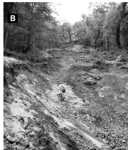
写真3 (A)下部谷壁斜面に多発した土層崩壊(B)3mの厚さの土層(樽前b火山灰をとまなう)に覆われる谷頭斜面に発生した土層崩壊。
