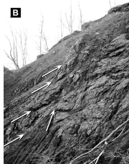
写真1 (A)砂岩層が膨縮し、軽微な破断および変形を示す砂岩頁岩互層。円内はスケールのペン。 (B)崩壊面に露出する頁岩～頁岩優勢互層に、10cmほどの間隔で発達する高角の亀裂(矢印)。
