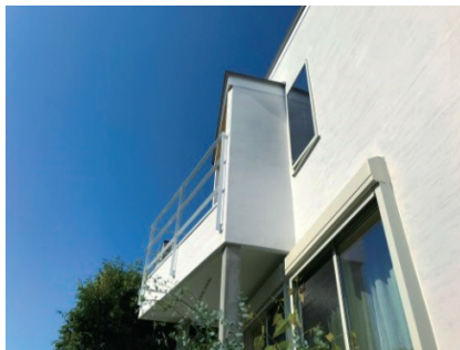
図10) ベランダの垂れ壁・南に向けて大きくなる形状
