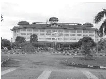
[写真13] ポート・ケラン（全景）
